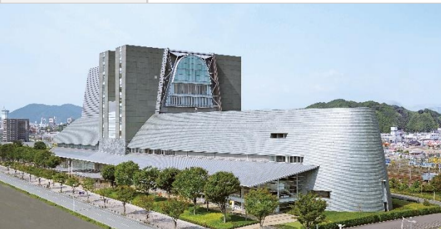
グランシップの消火設備を施工しました。
