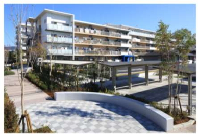
県営住宅今沢団地
