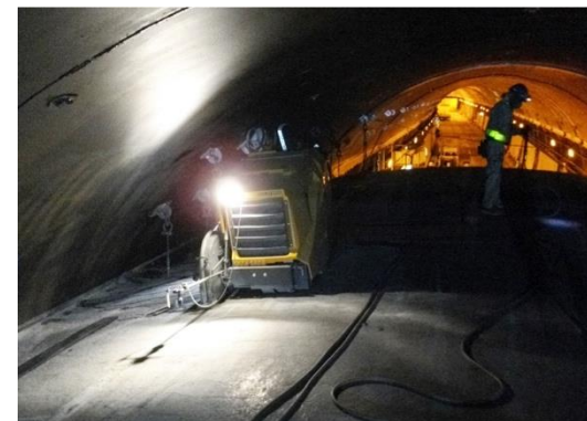
トンネルの内の補修工事
